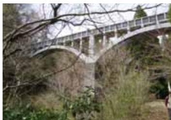
第3号水路橋(通称:めがね橋)
