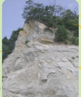
大津層の断面が見られます 石が落ちてくる可能性がある ので近づかないでください
